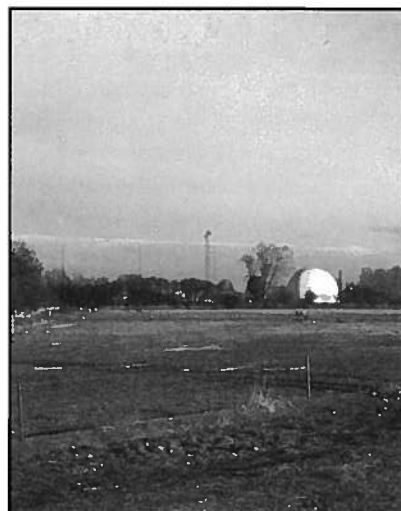
En del af FE-stationen på Aflandshage på Amagers sydvest-pynt
